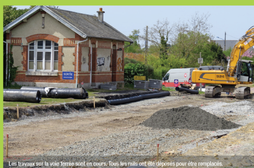
Les travaux sur la voie ferrée sont en cours. Tous les rails ont été déposés pour être remplacés.
